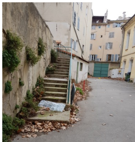
Cour nord/est, vue du soutènement Cliché Camebat
