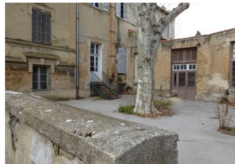
Cour nord/est, vue de la cour haute, Cliché Camebat
