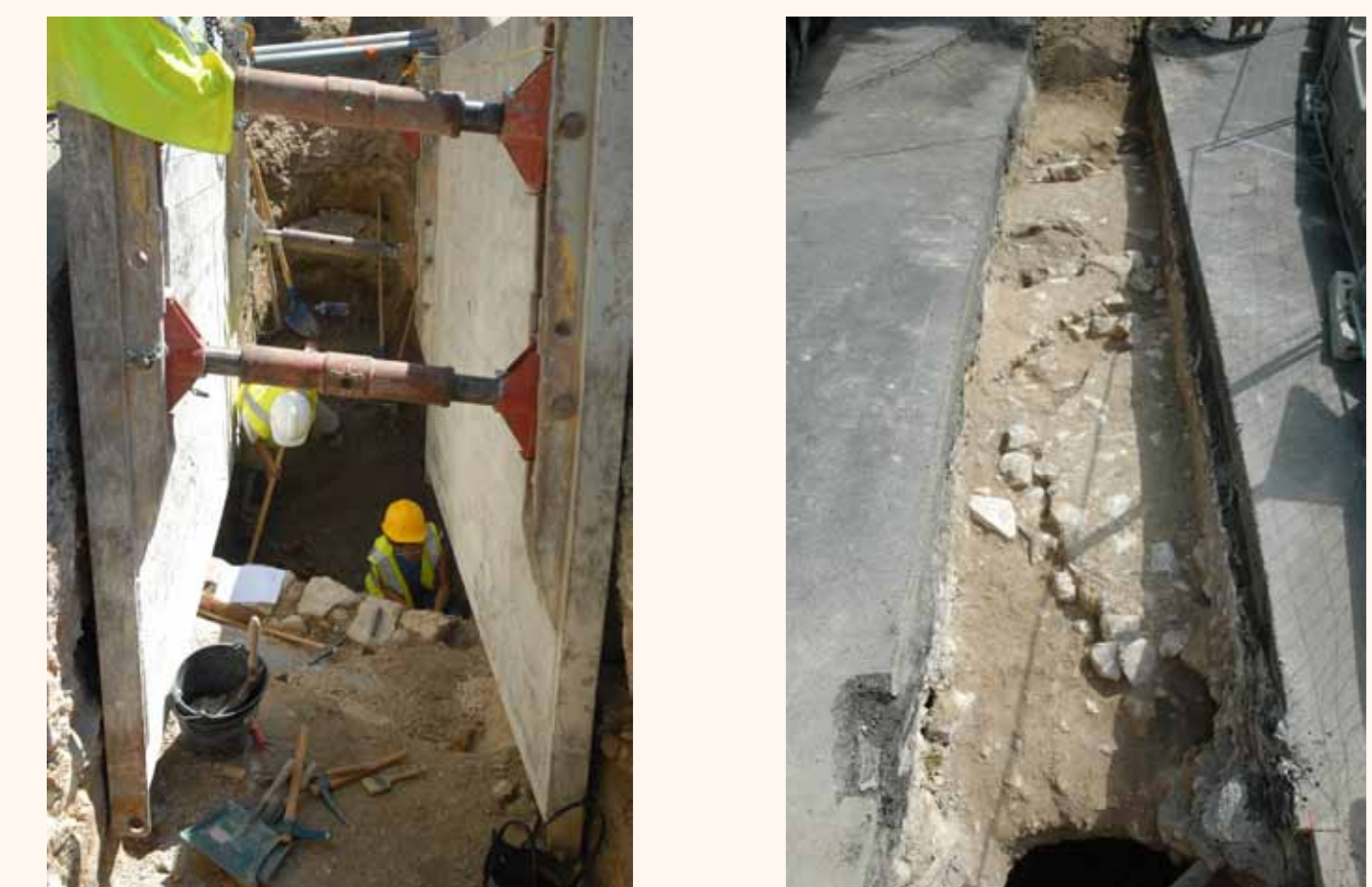
Percement voie Georges-Pompidou Fouille programmée, diagnostic et fouilles préventives, 1998, 2005, 2006-2007
