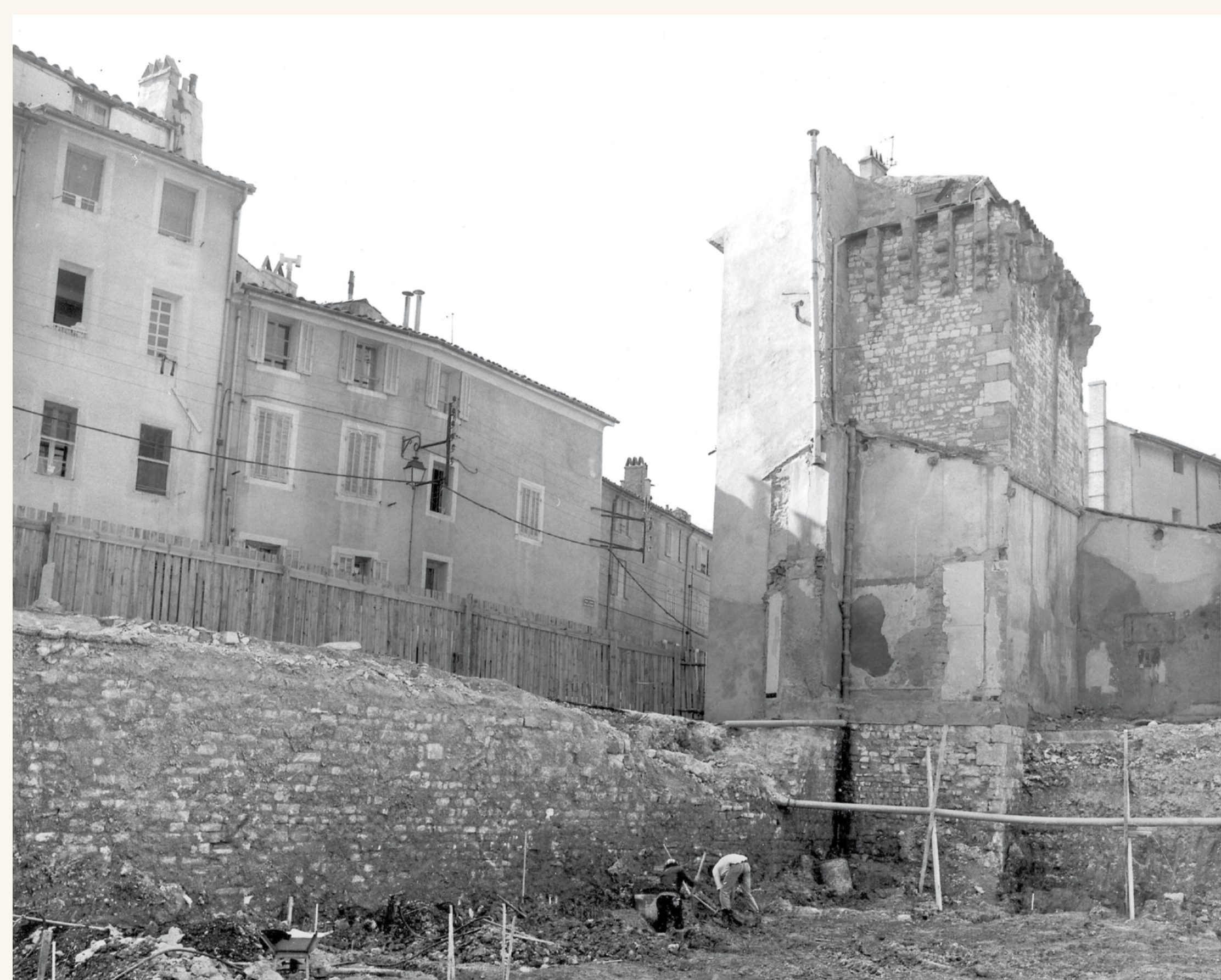
La tour Bellegarde et sa courtine orientale, lors de la construction du parking Bellegarde.
