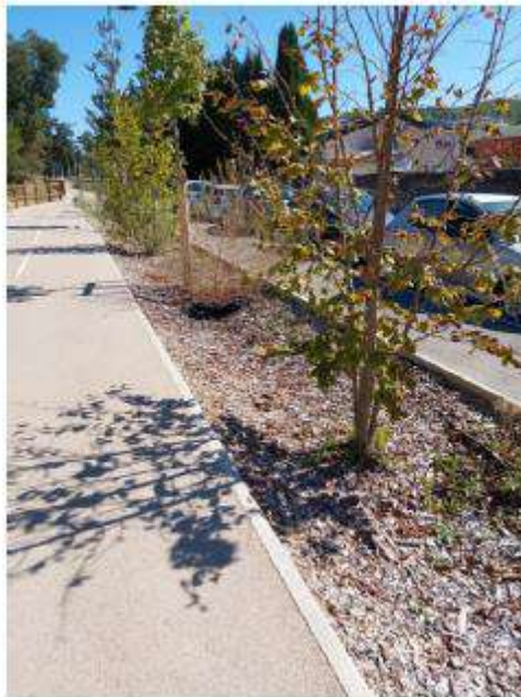
Noue d'infiltration plantée en accompagnement de la nouvelle piste cyclable du chemin du viaduc (crédits photo Ville d'Aix) - Rapport annuel sur la situation de la ville d'Aix-en-Provence en matière de développement durable pour 2023
