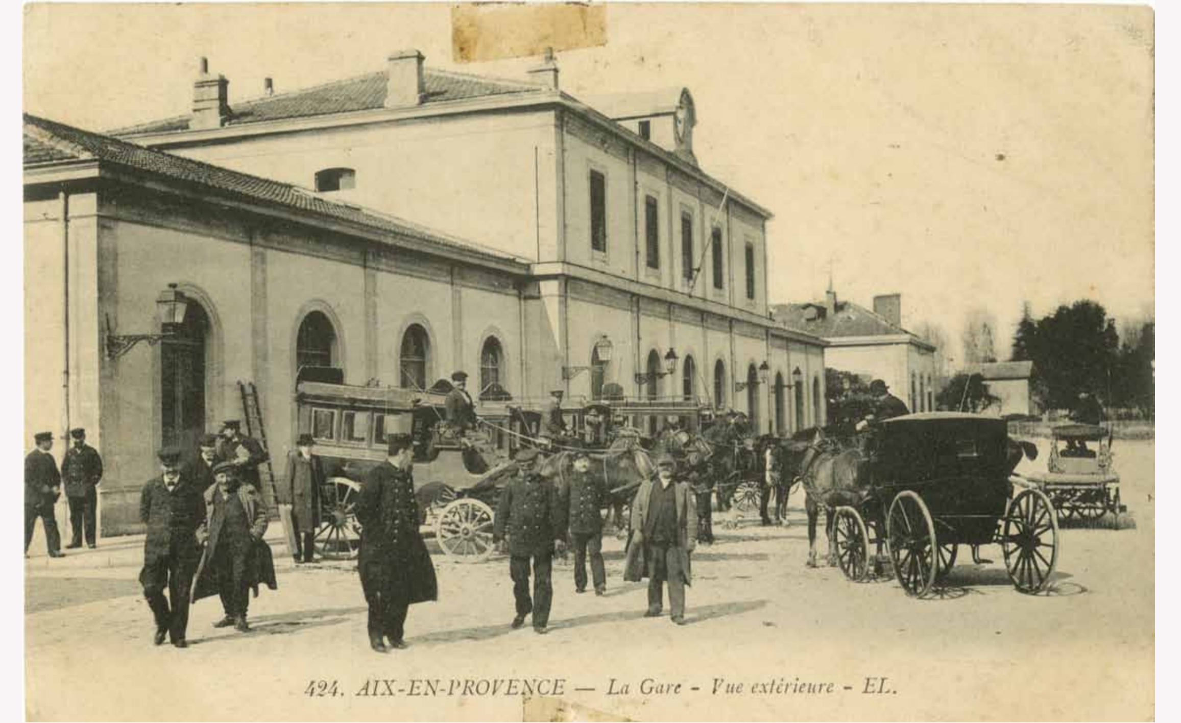
Photo prise en 1911 du nouveau bâtiment des voyageurs construit sur le cours d'Orbitelle. Il est toujours en activité.
