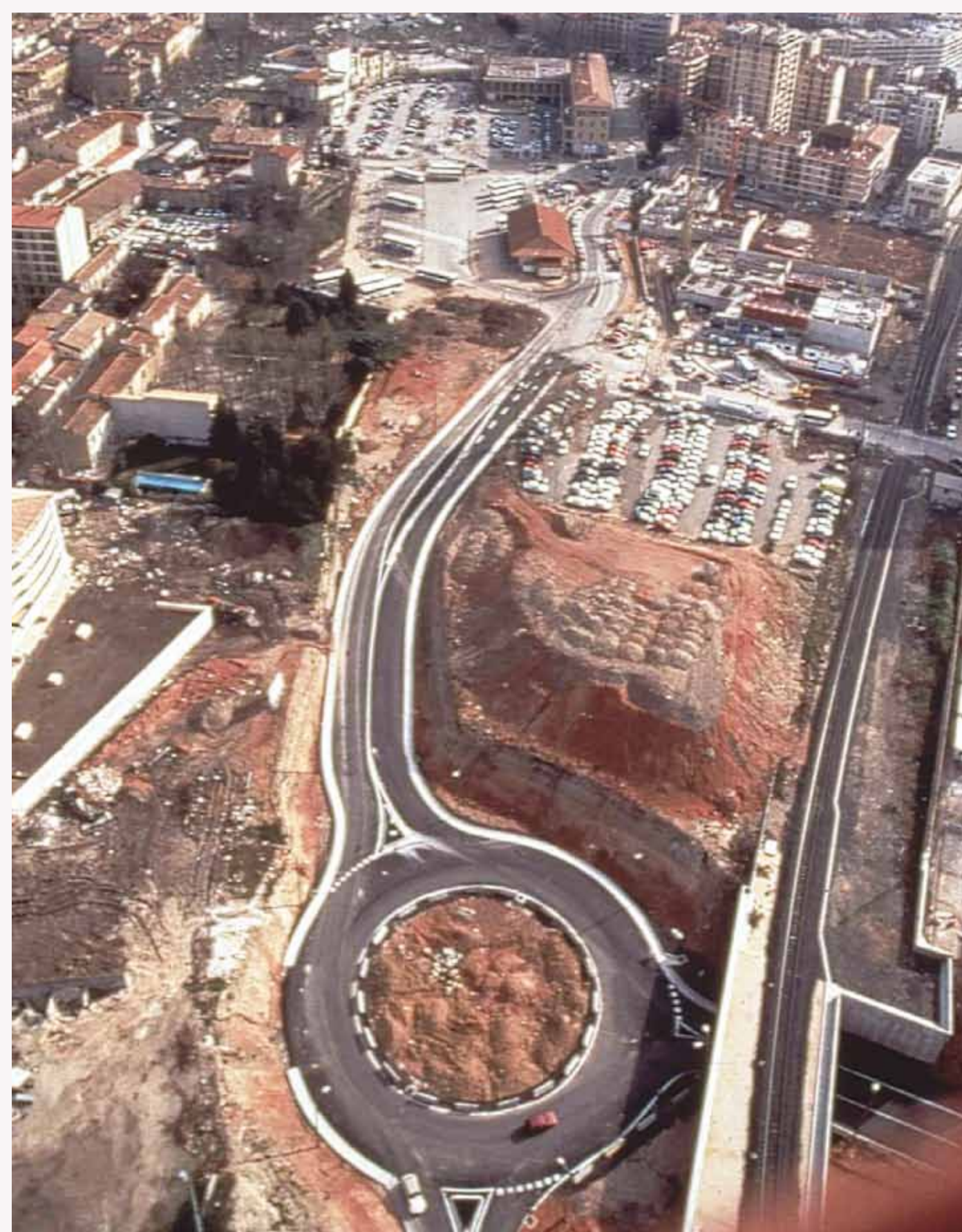
Construction de la voie Lapierre, artère principale du quartier Sextius Mirabeau.
