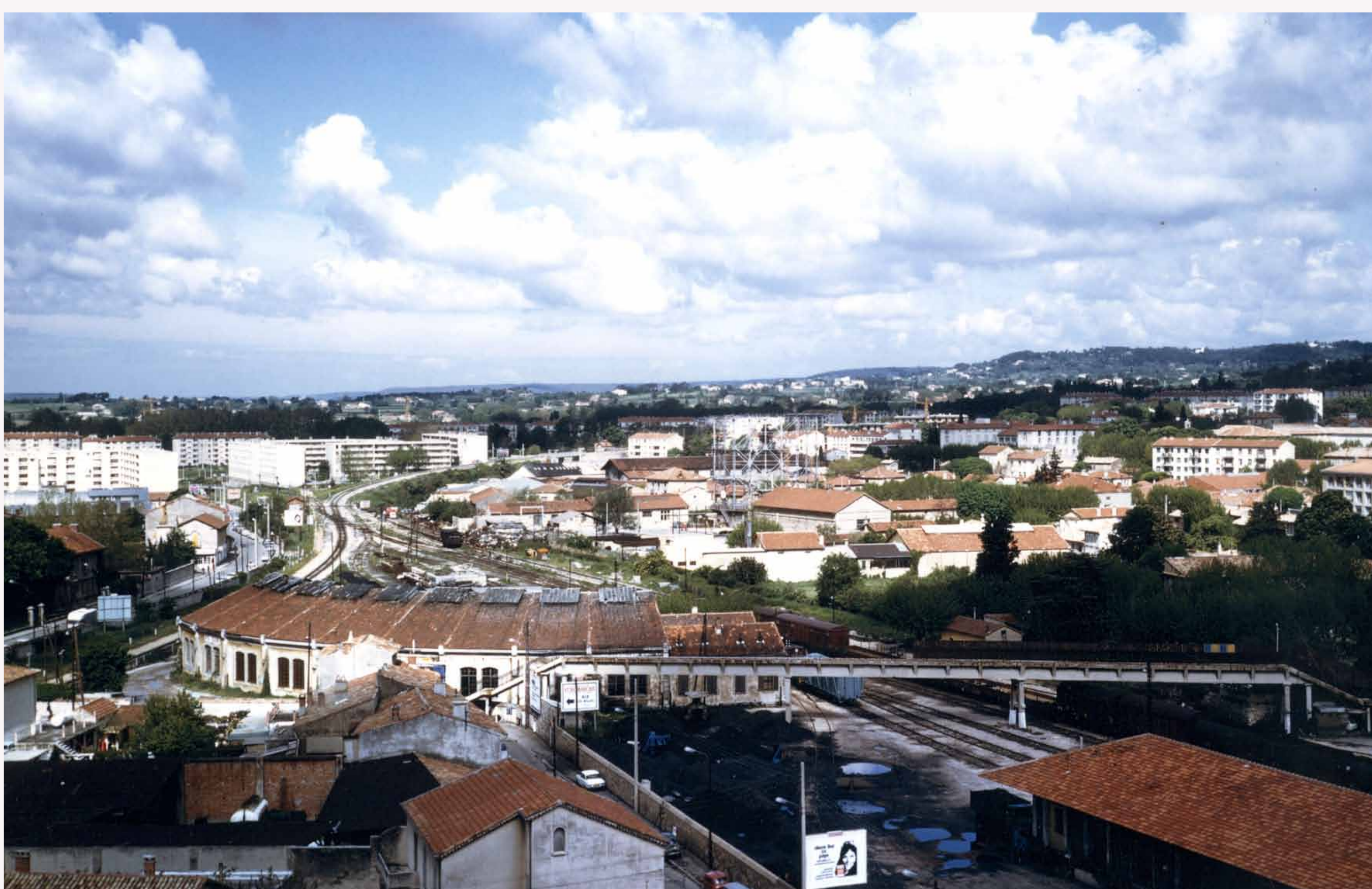
Vue de la rotonde des locomotives en 1974, peu de temps avant sa démolition.
