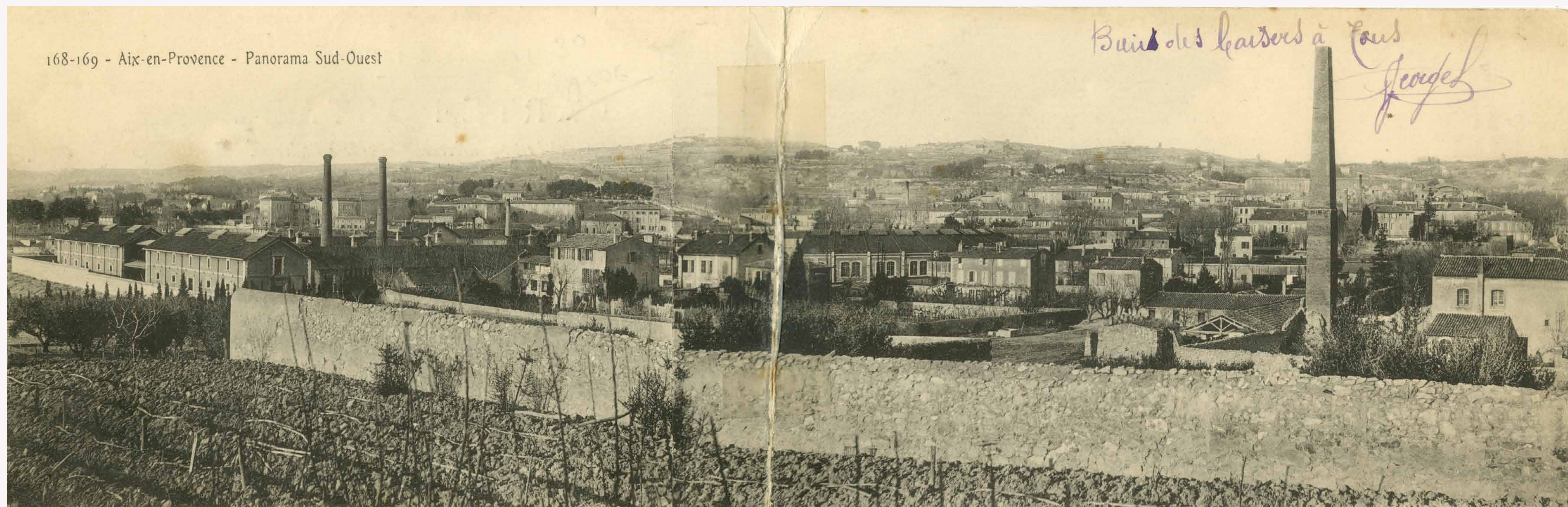
Vue panoramique, prise depuis le sud, du petit quartier industriel de la ville. À gauche, la manufacture des allumettes, au centre, la rotonde pour locomotives.
