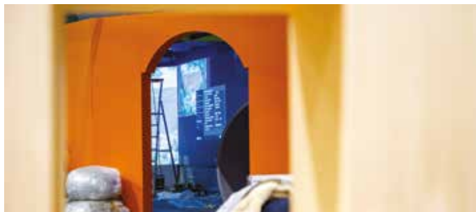
► La petite galerie Cézanne (en construction) © La Manufacture
