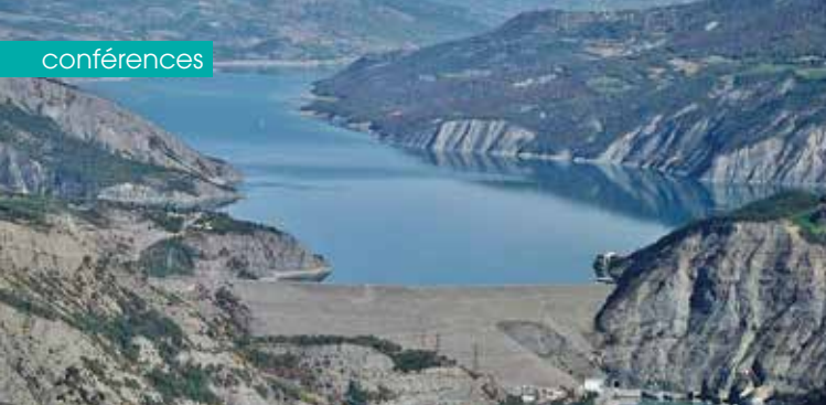
► Barrage de Serre-Ponçon © DR
