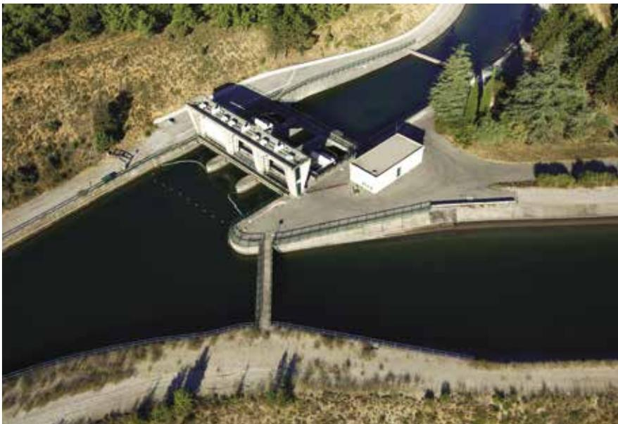
A Ginasservis, la prise de Boudre est la véritable origine du canal. Le canal mixte EDF/SCP (à gauche) se sépare en deux : en haut, le canal de Provence ; en bas, le canal EDF.
