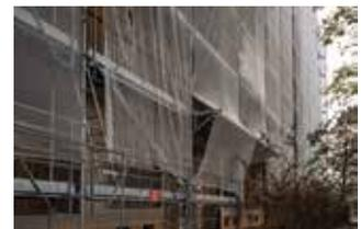
Félibre, cette résidence de 56 logements construits dans les années 1970. Sept mois de travaux seront nécessaires pour refaire les façades, isoler les logements par l'extérieur, revoir l'étanchéité, changer les menuiseries et les volets, remplacer les garde-corps et sécuriser les rez-de-chaussée.
