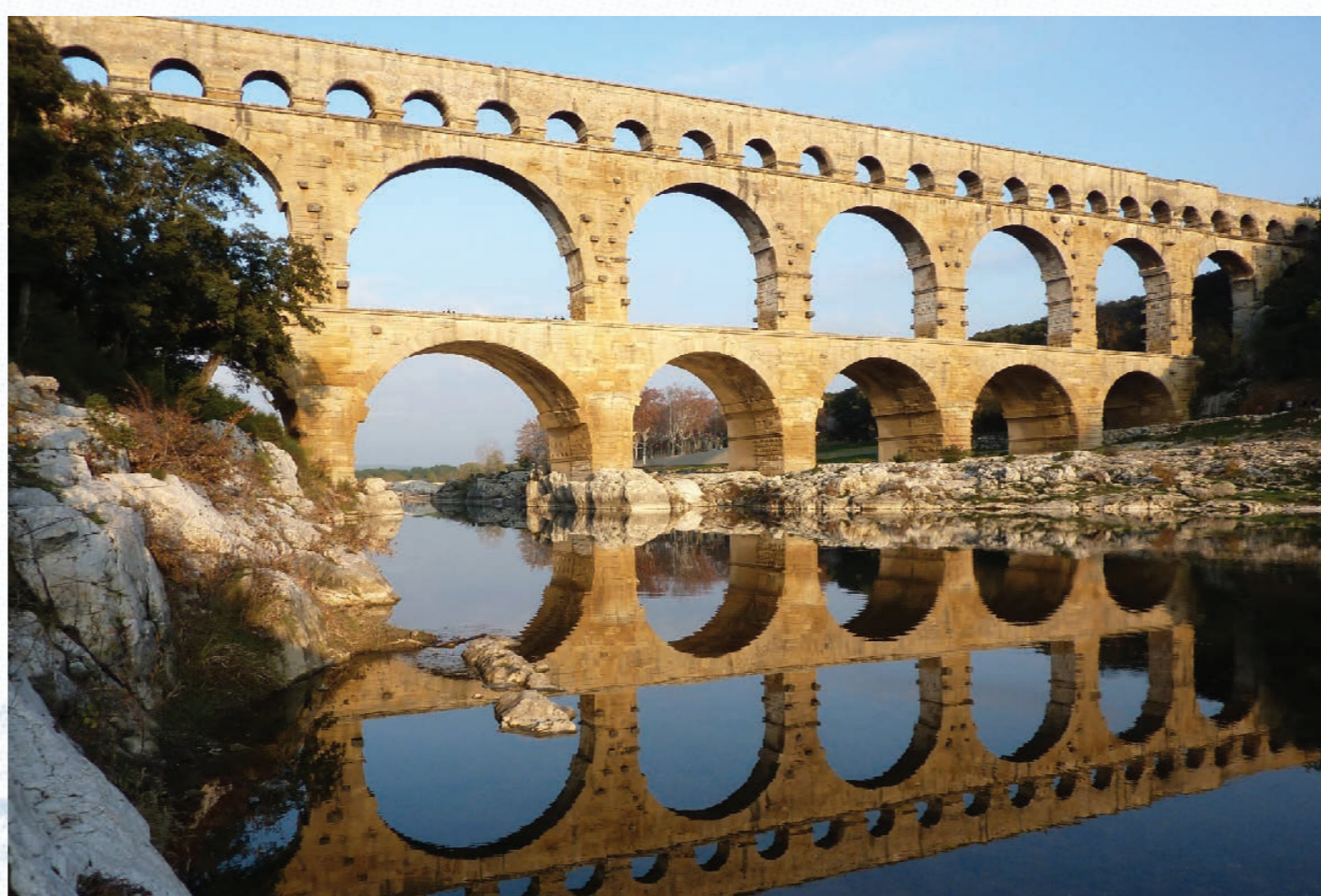
Arches ensablées du Pont du Gard.
