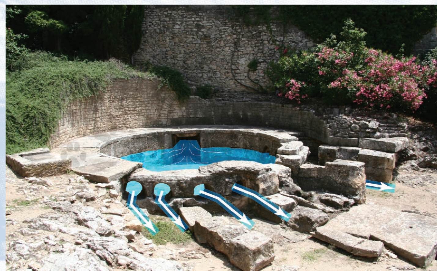
Nîmes conserve un castellum divisorium qui permet d'imaginer à quoi devait ressembler celui d'Aix-en-Provence: l'eau arrivait dans un bassin circulaire, puis s'écoulait dans des tuyaux dont on voit encore les orifices circulaires.
