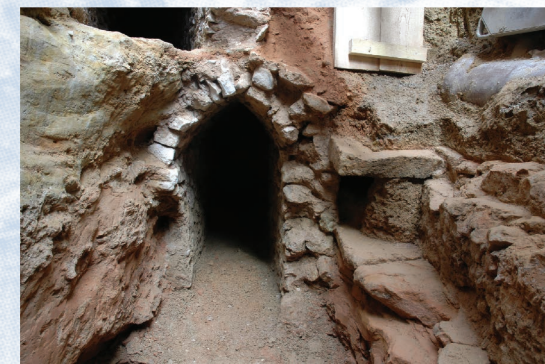
Vue en coupe de l'aqueduc mis au jour dans la rue du Bon-Pasteur.
