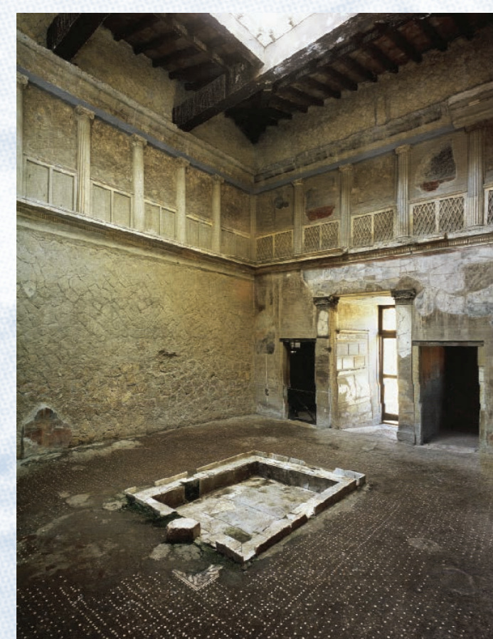
On retrouve le même dispositif dans la maison samnite à Herculanum (Italie) où le bassin situé au centre de l'atrium toscan, recueillait l'eau de pluie depuis l'ouverture dans le toit.
