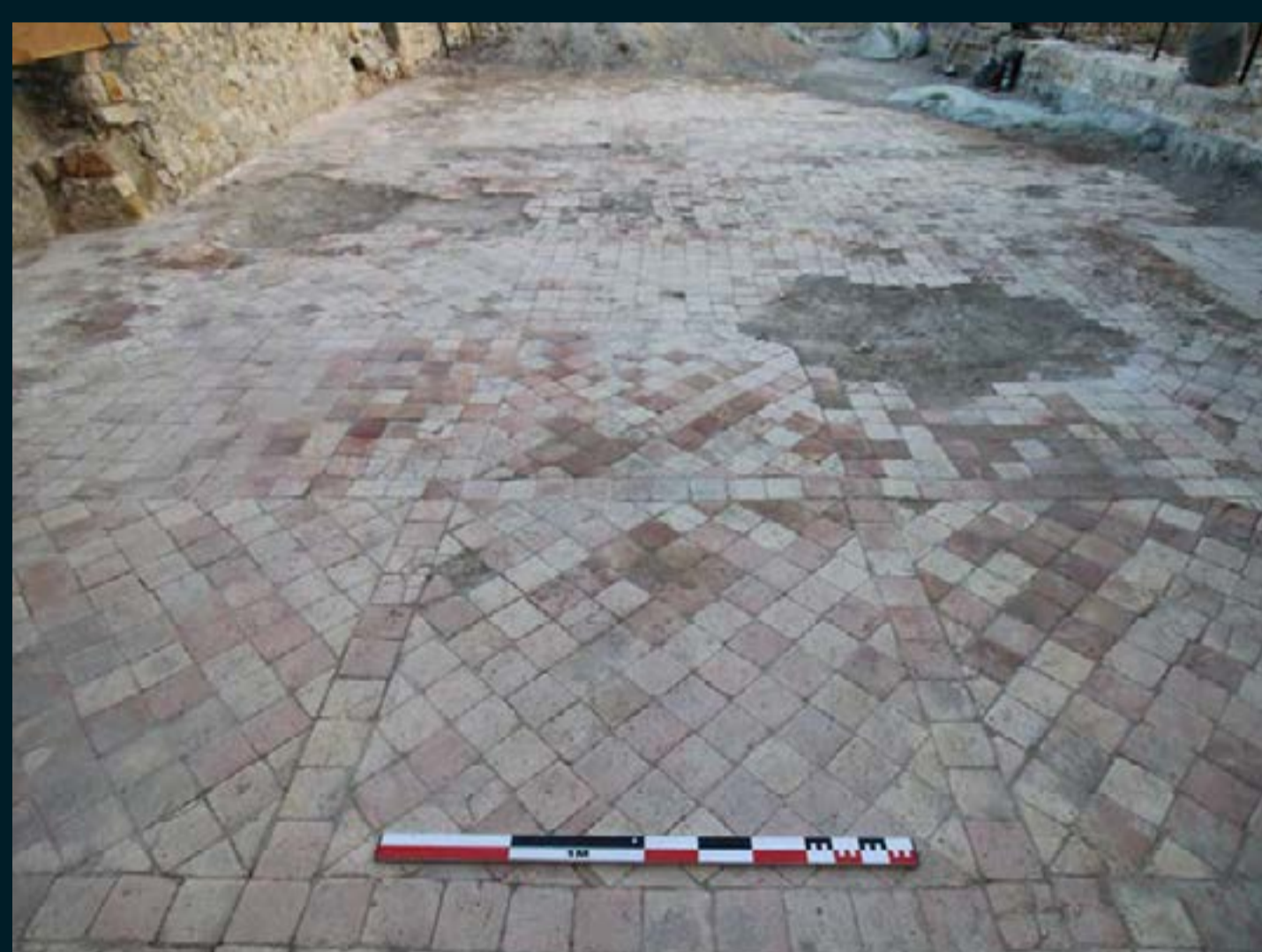
Salle de la herse, pavement de terre cuite (cl. E. Tomas)
