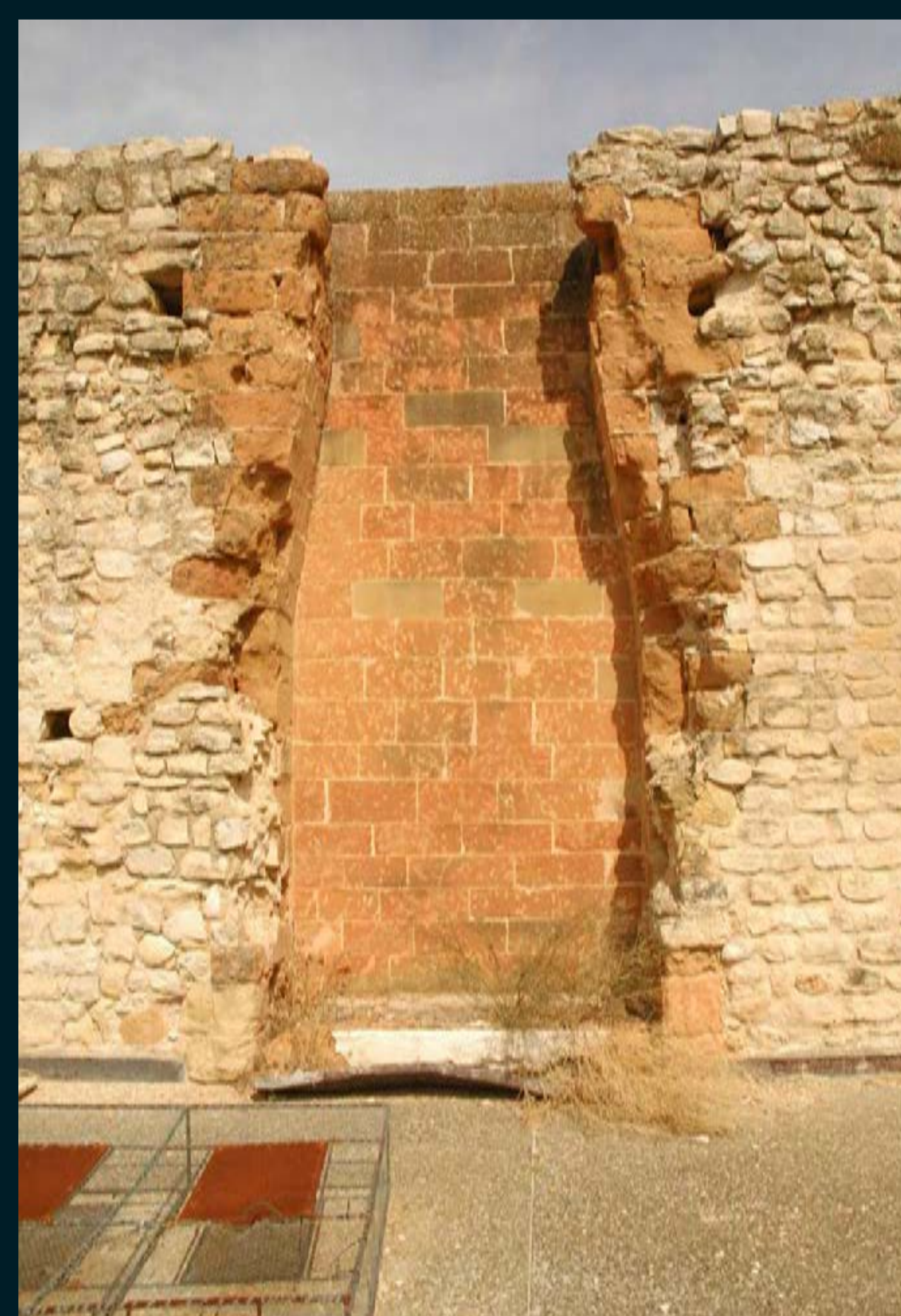
Salle haute du bâtiment ouest, détail de la cheminée en safre.
