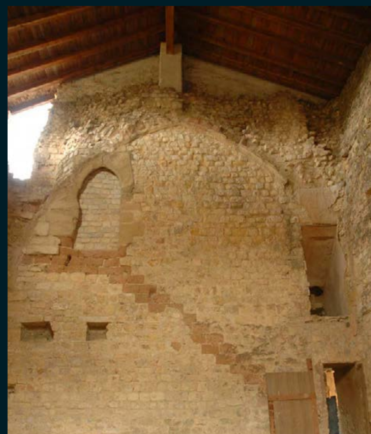
Photographie de l'étage de la tour sarrasine.
