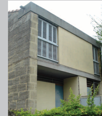
Pignon parementé en pierre du Pont-du-Gard. Cliché Claudine Bron.
