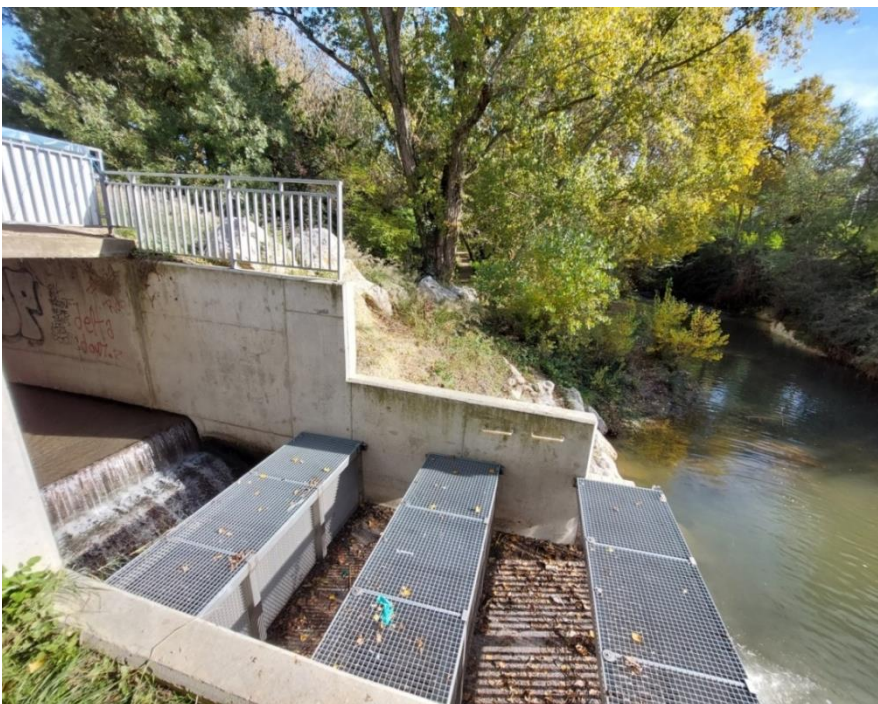
Dispositif innovant de collecte des macro-déchets exutoire pluvial du Krypton (crédit photo Ville d'Aix)
