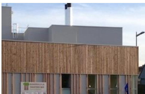
La chaufferie bois d'Aix-en-Provence, photo APEE
