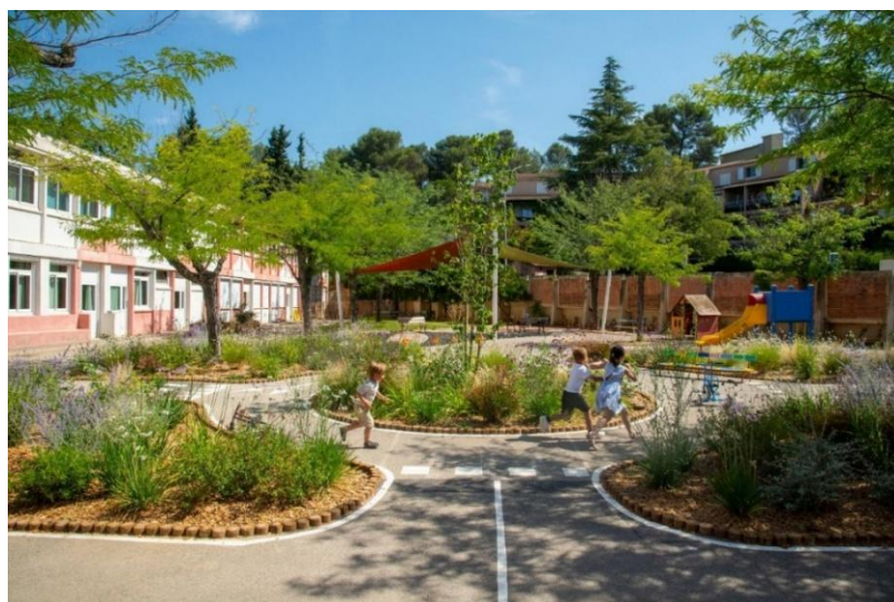
Ecole du Val Saint-André, après travaux (crédit photo ville d'Aix)
