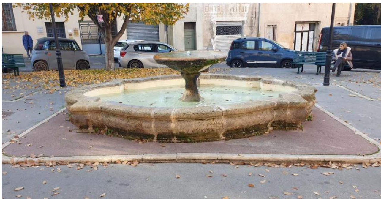
Fontaine Miollis, dont l'étude de mise en circuit fermé estime l'économie d'eau à plus de 2000m 3 annuels (source : BLD Water Design, AMO ville d'Aix)
