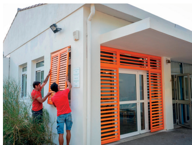
Installation notamment de ventilateurs - plafonniers dans les écoles.
